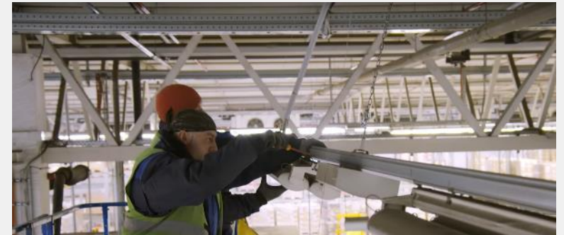
Planung und Steuerung des gesamten Projektablaufs
